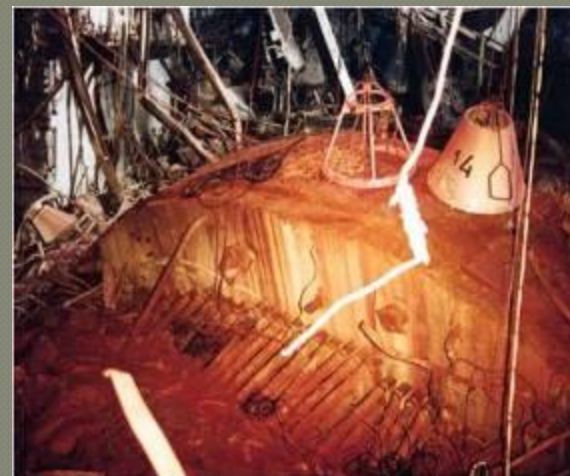
Крышка реактора после взрыва
