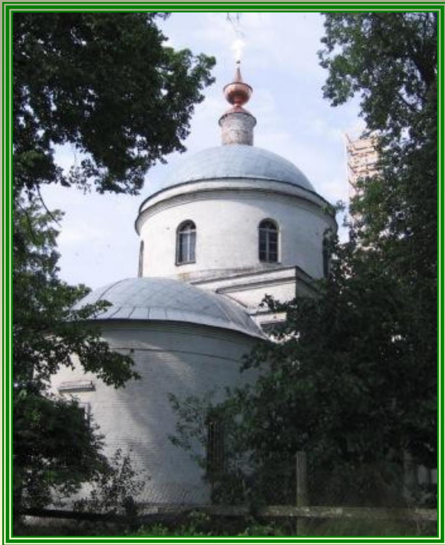
***Ротонда завершается глухим барабаном с карнизом из трех напусков в четверть кирпича. После барабана идет тонкая перетяжка. Нижняя часть главки решена в виде вазы или полушария, разделанного ложками. Венчается глава маленьким шпилем с яблоком и крестом простой формы. Такая же главка, но в миниатюре находится и над трапезной.***
