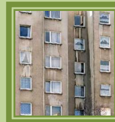
Использована простая фасадная краска.
