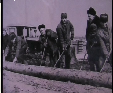
Строительство одного из объектов
