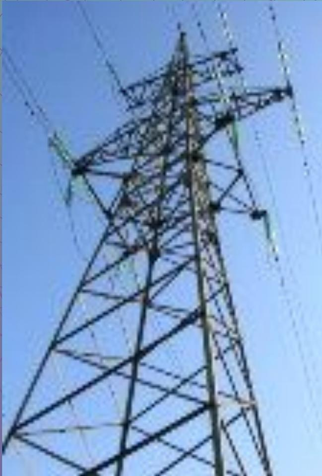
Провода работающей линии электропередач создают в прилегающем пространстве (на расстояниях порядка десятков метров от провода) электромагнитное поле промышленной частоты (50 Гц). Причем напряженность поля вблизи линии может изменяться в широких пределах, в зависимости от ее электрической нагрузки. Фактически границы санитарно-защитной зоны устанавливаются по наиболее удаленной от проводов граничной линии максимальной напряженности электрического поля, равной 1 кВ/м.
