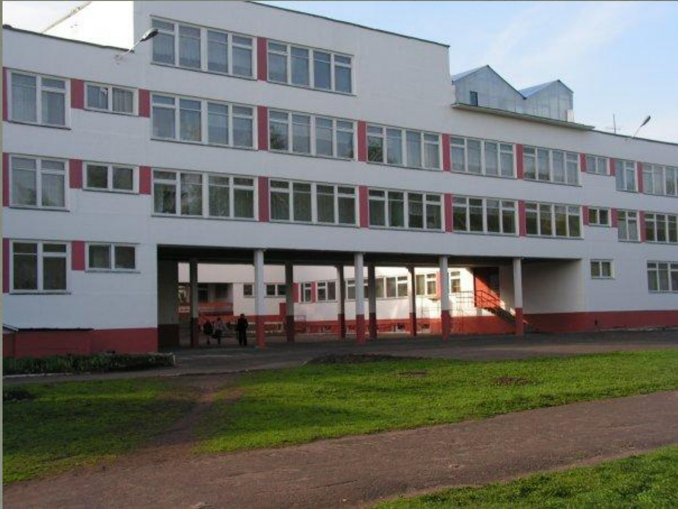
Фотография здания, высоту которого я измерял.
