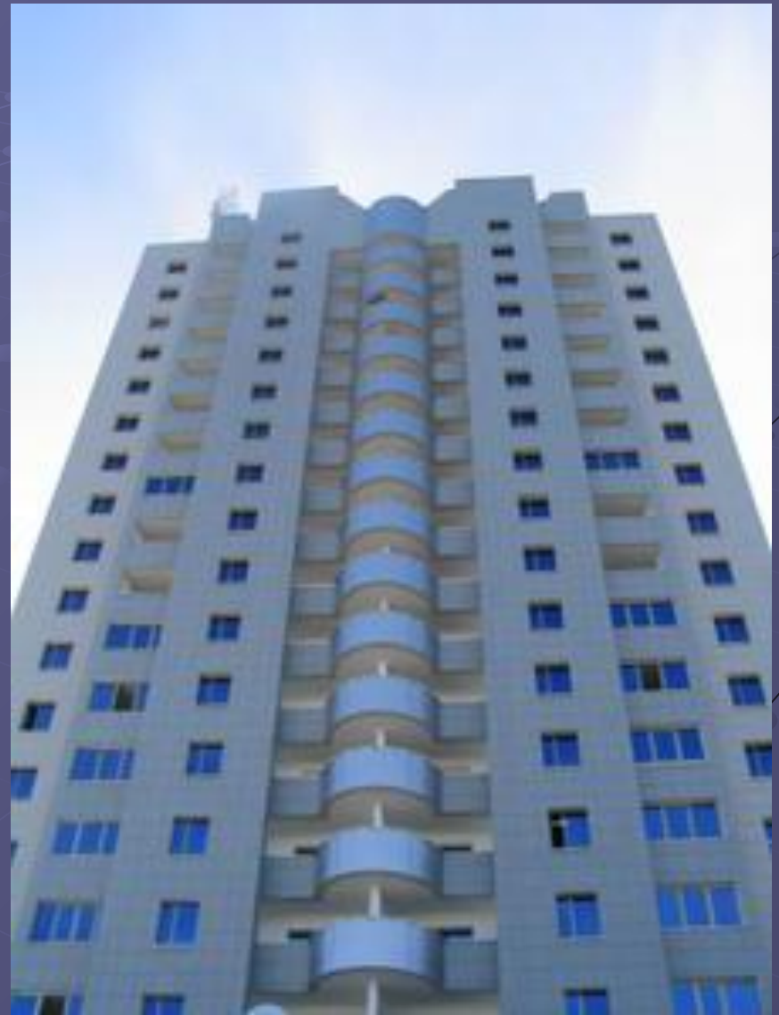
«Олимпийский» бизнес-центр, вид снизу-вверх
