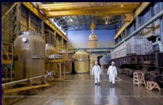
предприятия по переработке или изготовлению ядерного топлива
