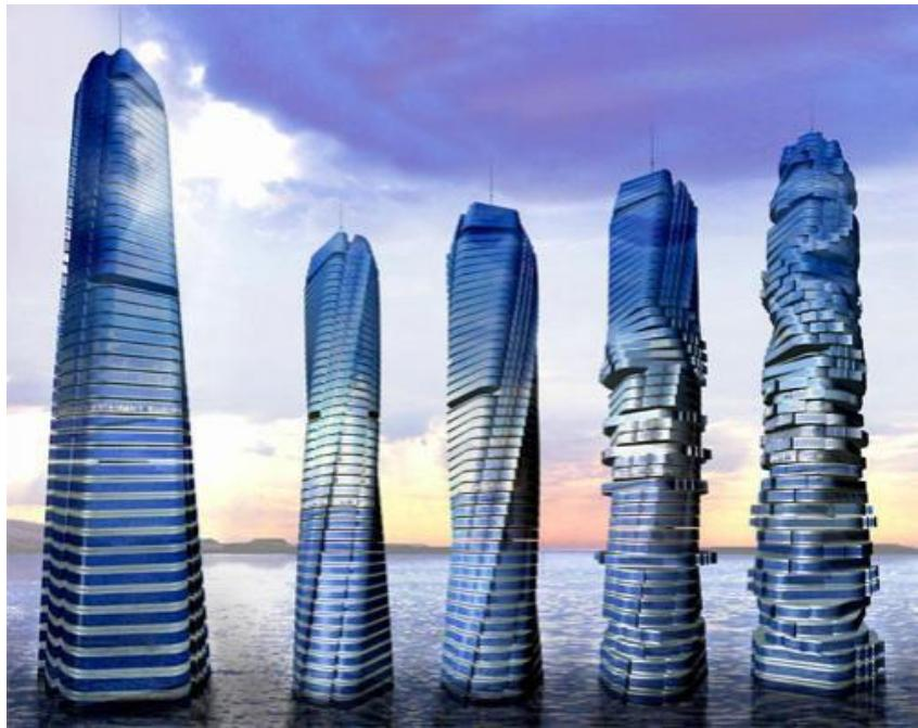
Еще один прорыв в будущее — вращающаяся башня, окончание строительства которой запланировано на 2009 год. Time Residences Tower высотой 170 метров поворачивается на 360 градусов со скоростью 5 миллиметров в секунду за счет солнечной энергии и делает полный оборот за 7 дней.
