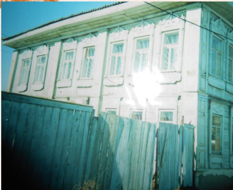
Здание первой начальной школы в д. Московка
