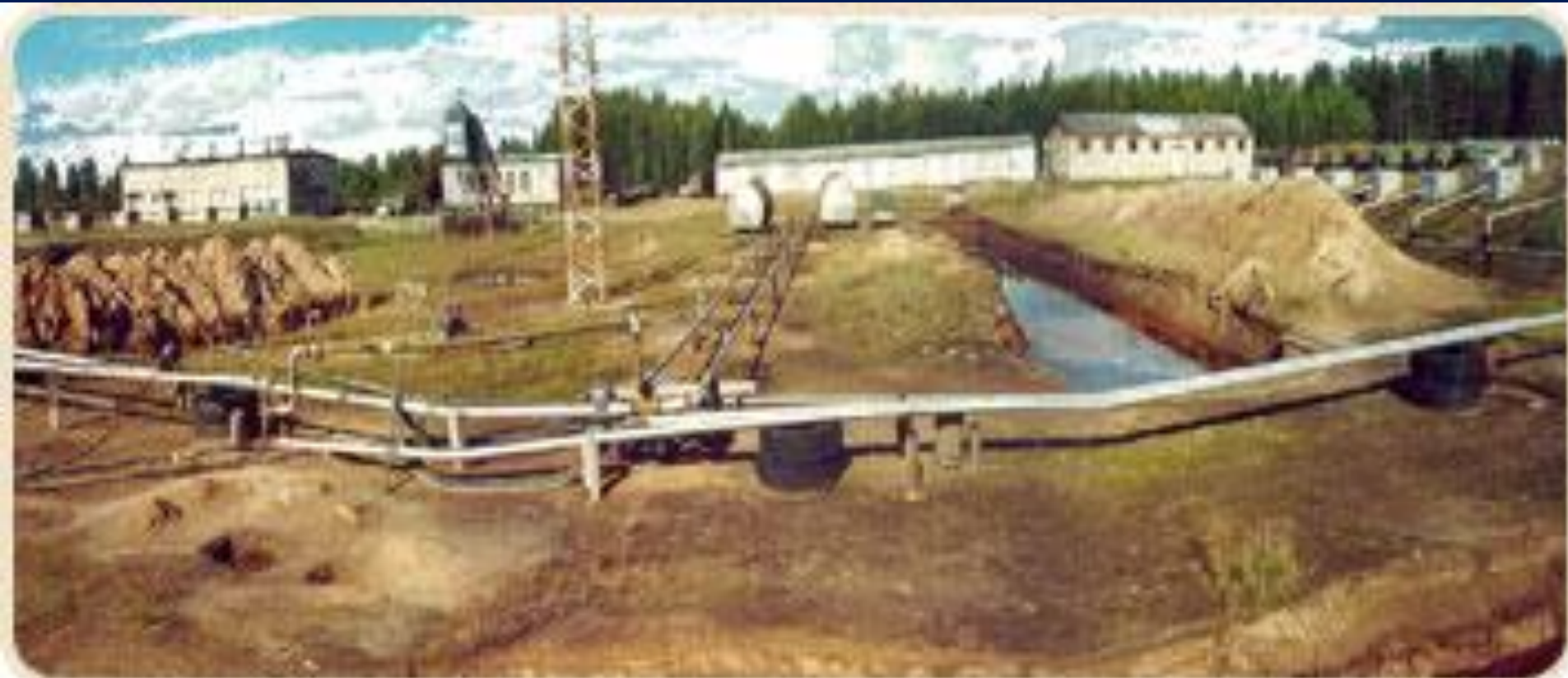
Сооружение для очистки подземных вод
