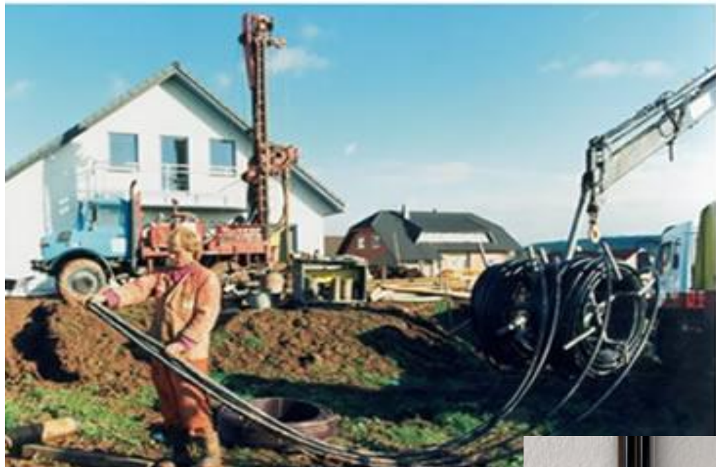
Подготовка двойного U-образного зонда для грунтовой скважины
