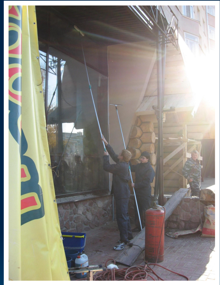
ГК ПИР, ресторан «Елки-палки», октябрь 2007 г. послестроительная уборка
