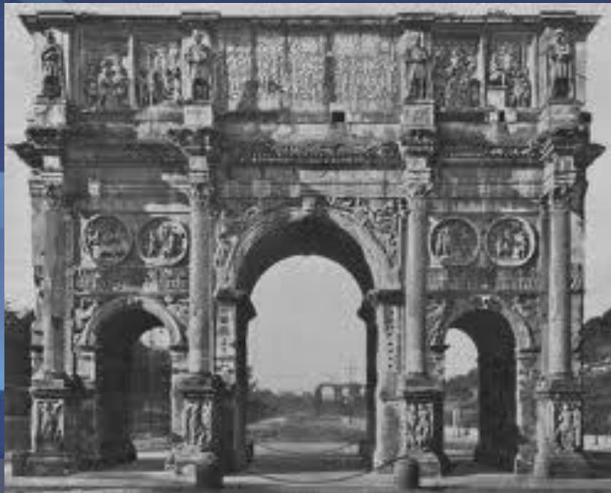
Арка имеет высоту 21 м, ширину 25,7 м и глубину 7,4 м. Центральный пролёт 11,5 м высотой и 6,5 шириной, боковые: по 7,4 м и 3,4 м. Основная часть монумента выполнена из мраморных блоков, аттик кирпичный, облицованный мрамором.
