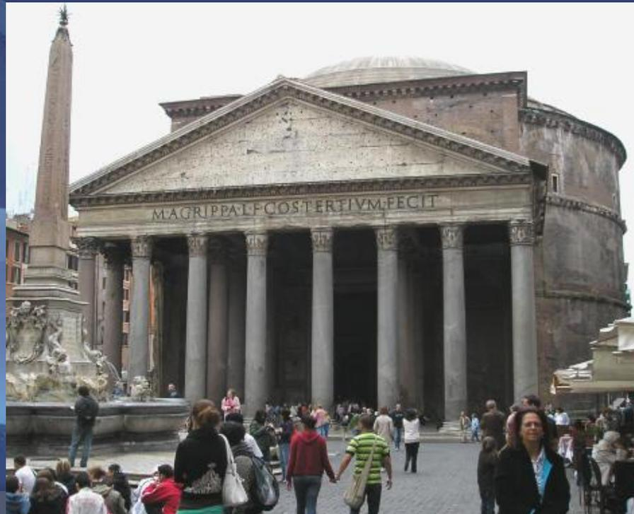
Кирпично-бетонная ротонда Пантеона перекрыта полусферическим куполом (диаметр свыше 43 м). Купол состоит из окружностей, которые легко прочтываются благодаря кессонированному потолку. Купол со стенами образует единую оболочку, содержащую внутри всё пространство, соответствующее внутреннему объёму цилиндра и половине сферы. Ранее поверхность купола украшали звезды, но позже их растащили.
