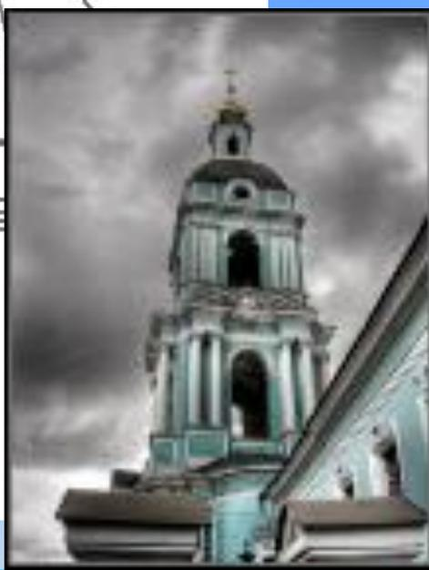
Вмеры отверстий делаются такими, чтобы частота колебаний воздуха в них совпадала с частотой звучания колокола (3).
