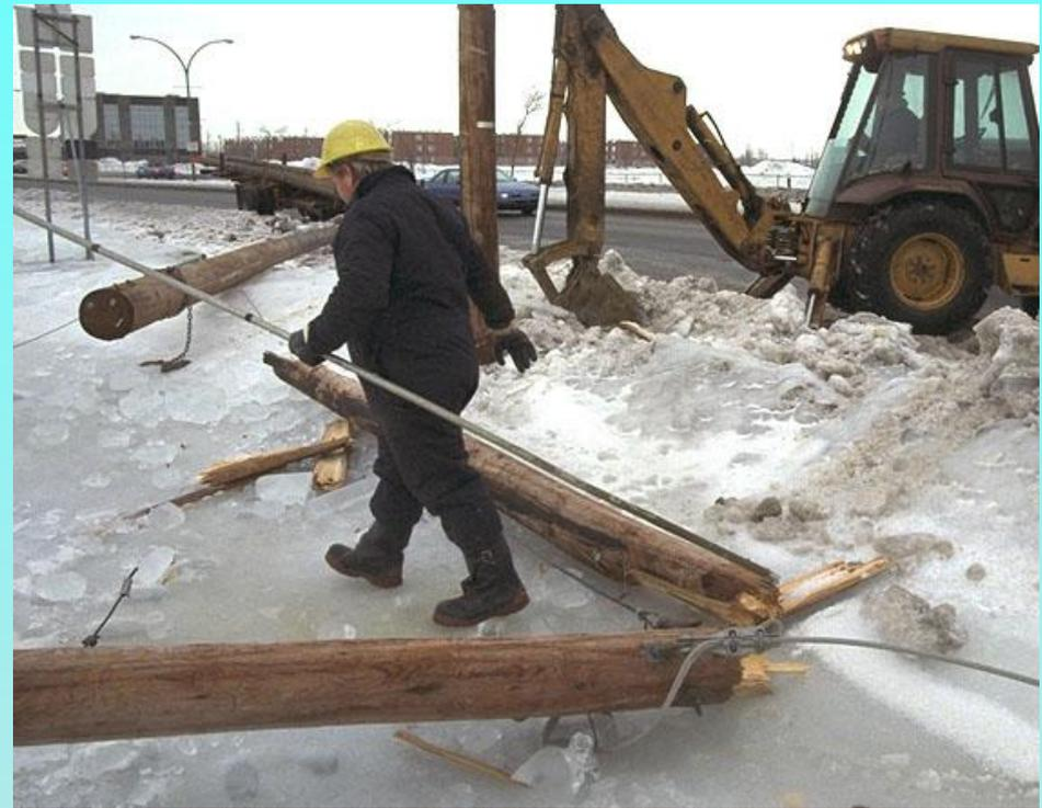
РИСУНОК 7В-20: ОПАСНЫЕ РАБОТЫ НА ПОКРЫТОЙ ГОЛОЛЕДОМ ЗЕМЛЕ
