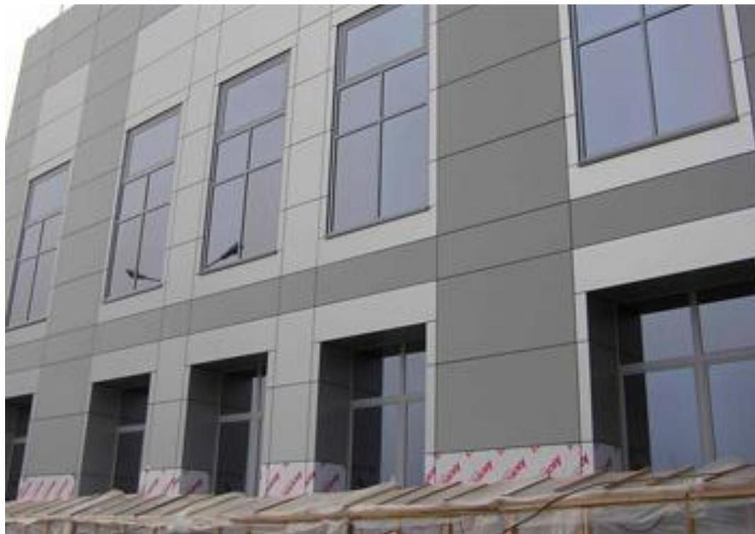
Из данной профильной системы КП-45 изготавливаются окна, витрины магазинов и других конструкций. Для нее характерна небольшая конструктивная толщина, а именно - 45 мм. Это зрительно делает конструкцию легче и позволяет монтировать в труднодоступных местах.
