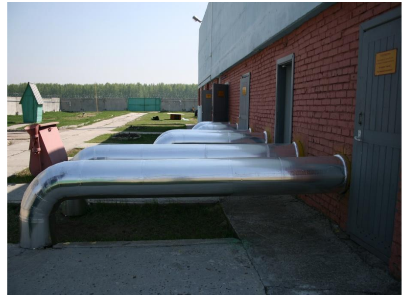
ТомТрансГаз – после реконструкции
