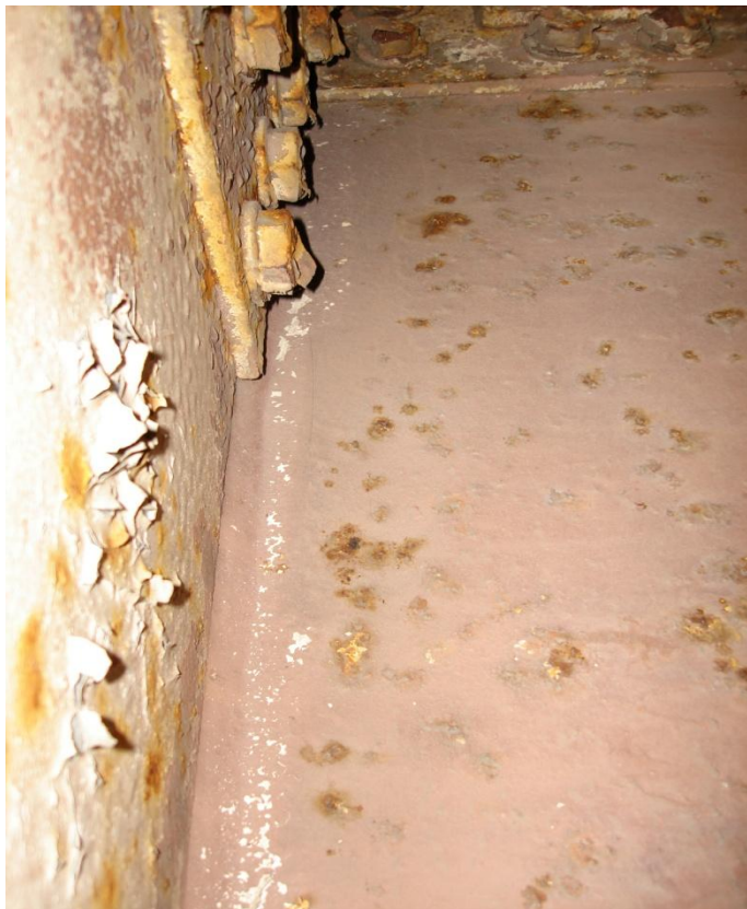
Внутренние полости металлоконструкций
