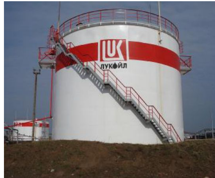
НефтьОргСинтез – после реконструкции
