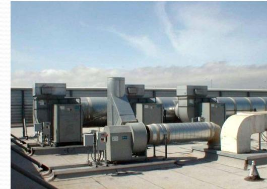
При витяжній вентиляції повітря вилучається з приміщення, а зовнішнє надходить через вікна, двері, нещільності будівельних конструкцій. Припливно-витяжна вентиляція поєднує першу й другу.
