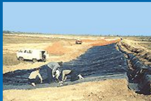
Укладка противофильтрационного слоя
