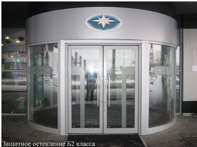
Защитное остекление В2 класса
