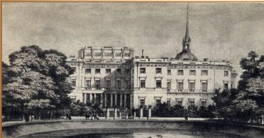
Главное инженерное училище (Инженерный замок)
