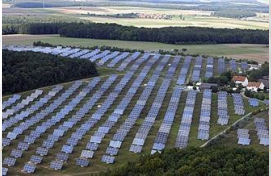
Солнечная электростанция в Германии
