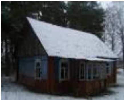
Одноэтажный многоквартирный дом
