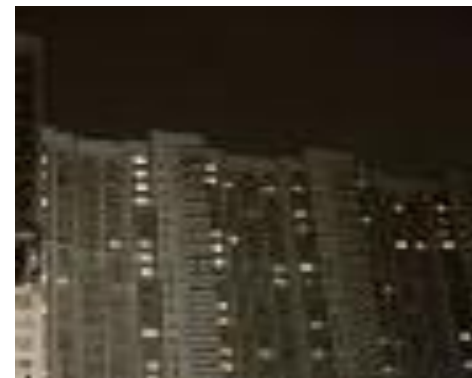
Многоквартирный высотный дом
