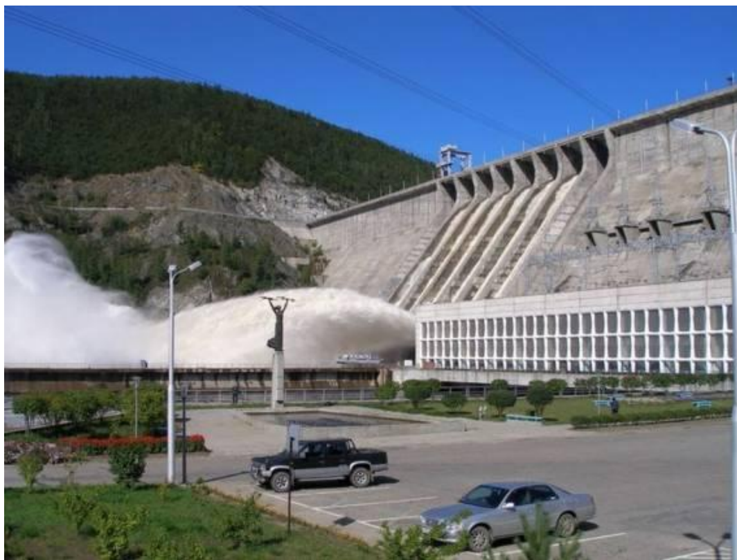
Плотина Зейской ГЭС (Амурская область) высотой 115,5 м
