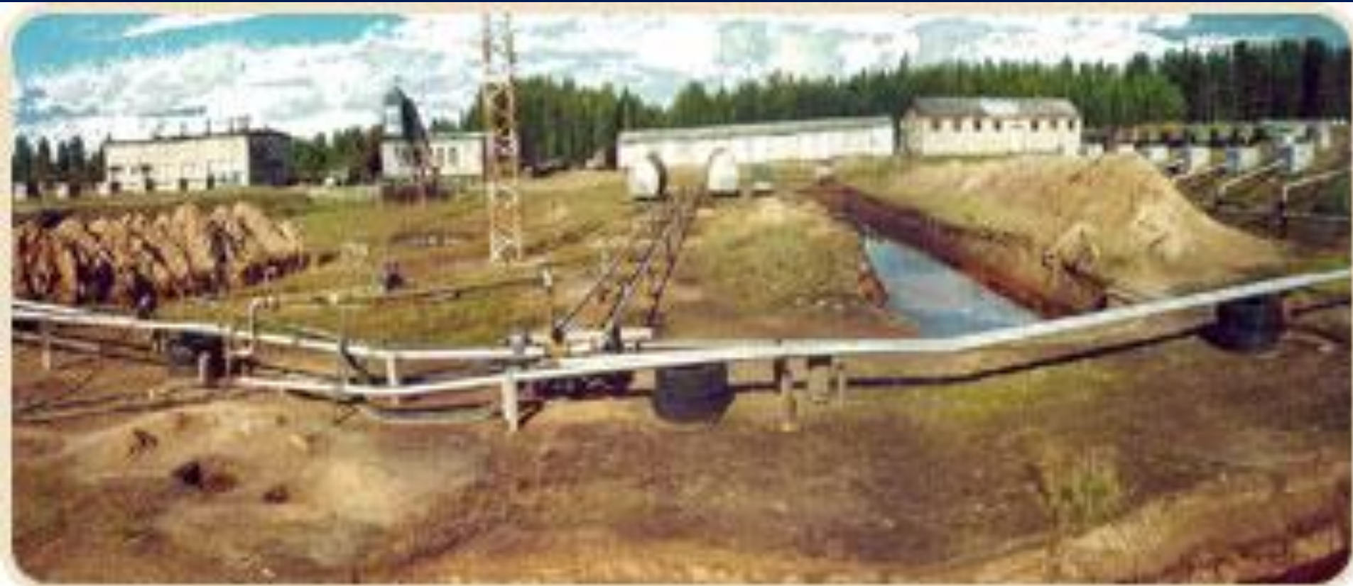
Сооружение для очистки подземных вод
