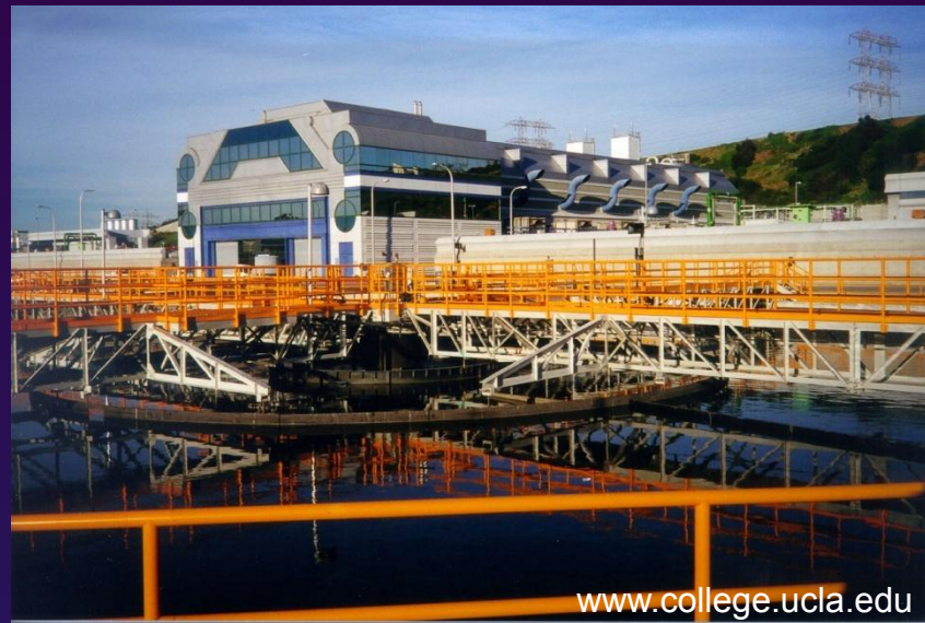
Вторичный отстойник
