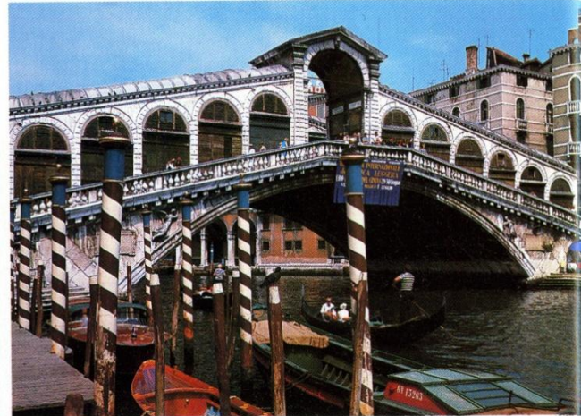
Мясной мост в Нюрнберге (Фляйшбрюкке; закончен в 1602 г.) — один из самых красивых мостов эпохи Возрождения в Германии. Образцом для него, вероятно, послужил мост Риальто в Венеции (справа), пролегающий через Большой канал и опирающийся на 10 000 деревянных свай, закрепленных в мягком грунте.
