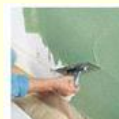
Покрывание участков у пола
