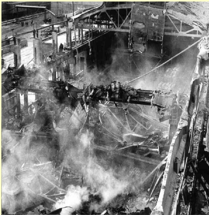
Печное отделение участка непрерывной разливки алюминия Братского алюминиевого завода после взрыва
