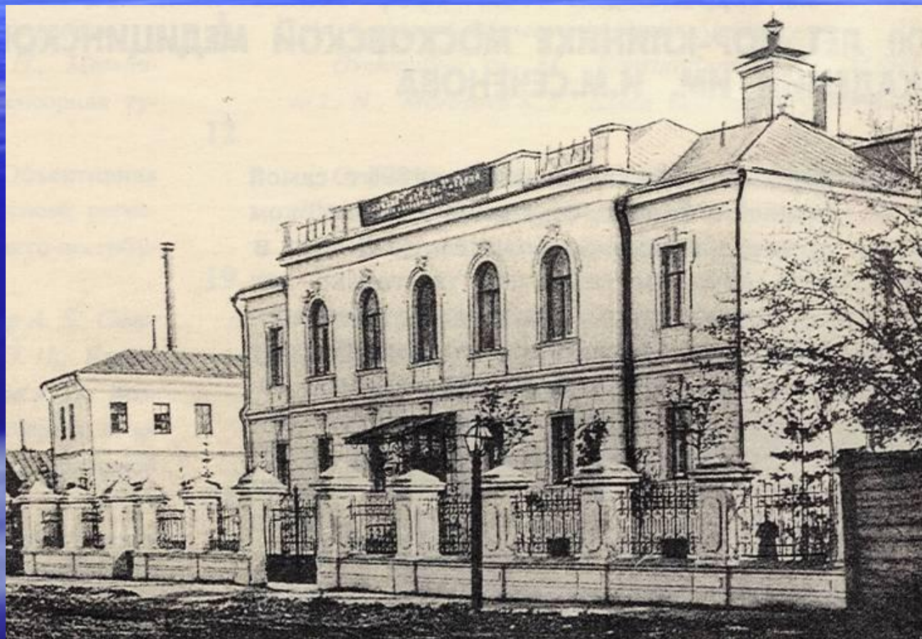
Старое здание клиники
