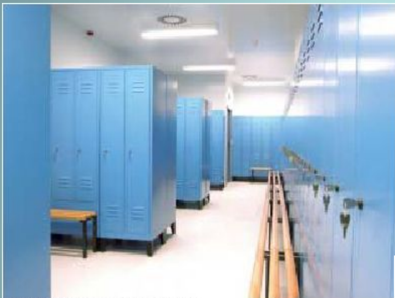
Отделка чистых помещений - шлюзы для персонала
