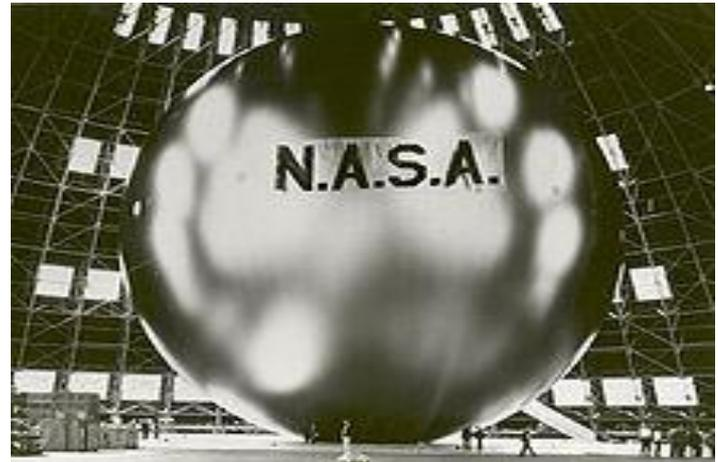
Пассивный спутник связи Echo-2. Металлизированная надувная сфера выполняла функции пассивного ретранслятора
