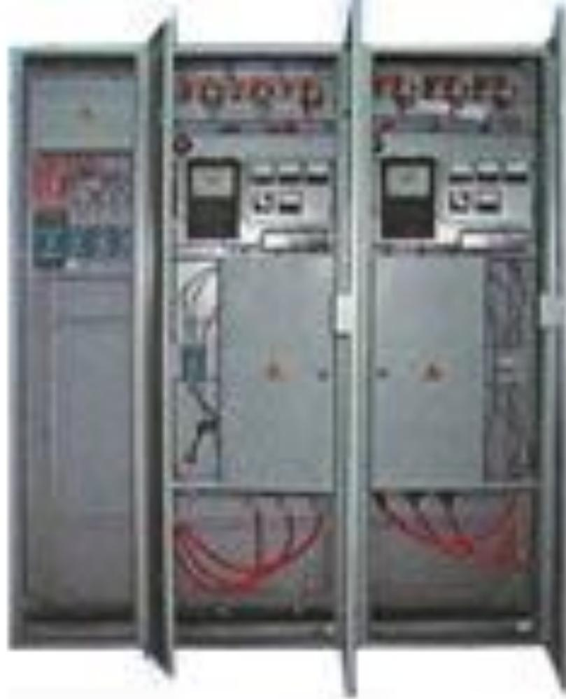
**Устройства вводно-распределительные ВРУ-8504А** для жилых и общественных зданий предназначены для приема, распределения и учета электроэнергии напряжением 380/220В в сетях трехфазного переменного тока частотой 50Гц, для защиты линий при коротких замыканиях и перегрузках, а также для нечастых оперативных включений и отключений.
