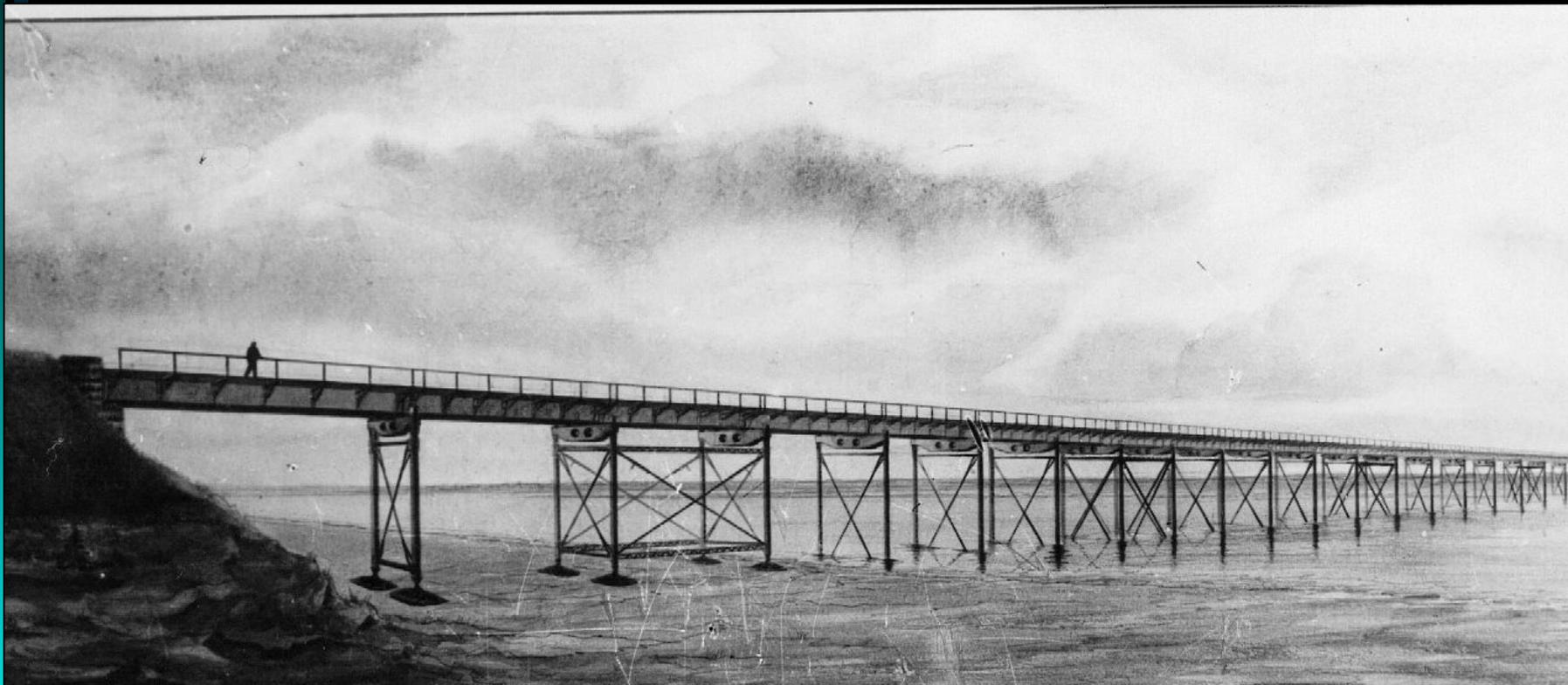
РЭМ-500 предназначена для быстрого устройства мостовых переходов через широкие, но неглубокие водотоки, через суходолы, а также для перекрытия брешей в земляном полотне (рис. 1).
