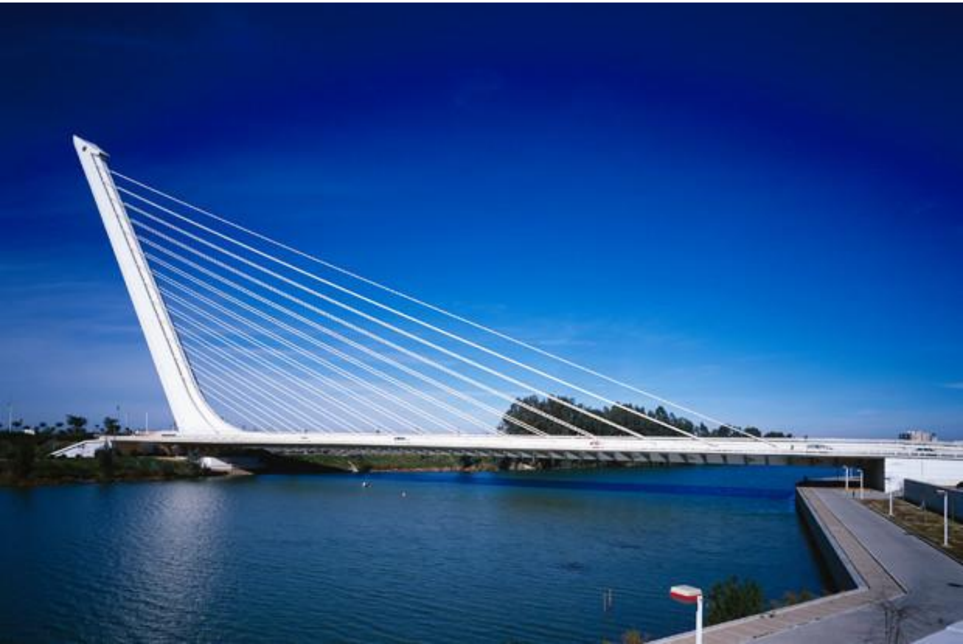
Мост Аламилльо, Севилья.
