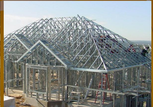
Основным материалом для **строительных стальных конструкций** в течение многих лет была **низкоуглеродистая сталь**. Растущие потребности строительной техники требуют снижения массы строительных конструкций и уменьшения их сечения, а также применения сталей с более высокими физико-механическими свойствами, что и привело к замене **углеродистых** сталей **низколегированными**.
