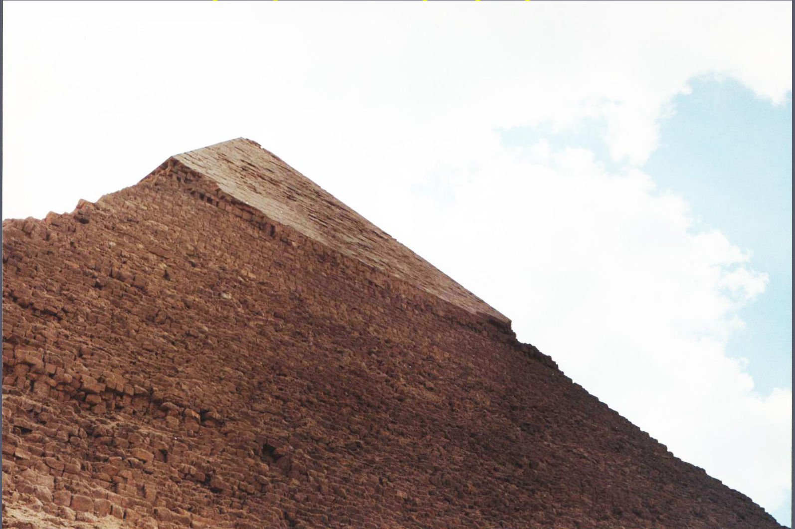
Фрагмент каменной кладки.
