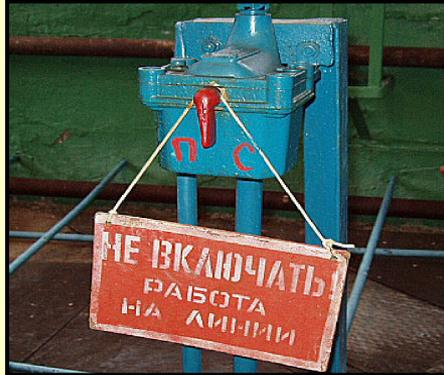
Электрическую схему вновь разобрать и вывесить на пусковую аппаратуру предупреждающую табличку
