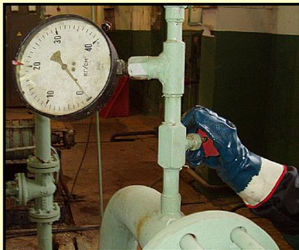
Перекрыть краны на манометрических сборках
