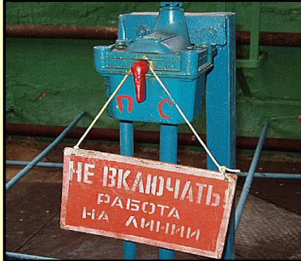
Вызвать электротехнический персонал, чтобы разобрать электрическую схему и вывесить предупредительную табличку на пусковую аппаратуру
