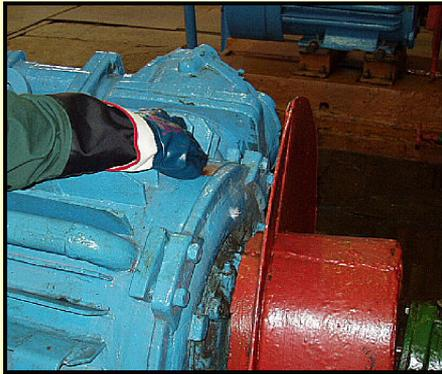
Проверить отсутствие вибрации насосного агрегата. При подозрении на повышенную вибрацию - вызвать службу вибродиагностики.
