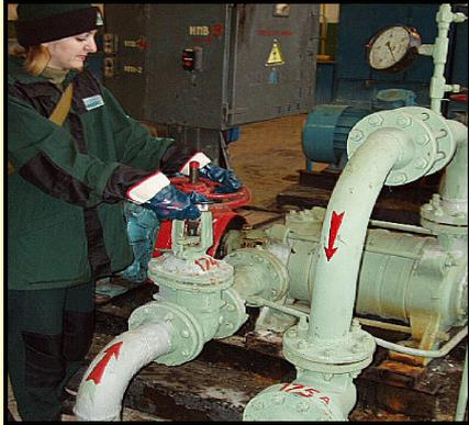
Открыть задвижку на приемном трубопроводе для заполнения насоса жидкостью
