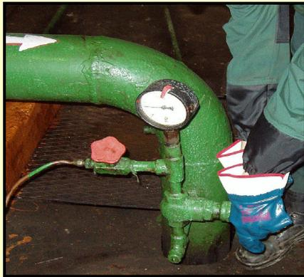
Слить жидкость из корпуса насоса и подводящих трубопроводов через дренажный вентиль
