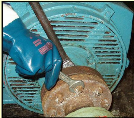
Установить крепление (пальцы), соединения полумуфт электродвигателя и насоса.
