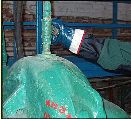
Сбросить остаточное давление из корпуса насоса через дренажный вентиль
