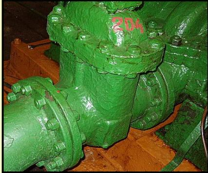
Произвести визуальный осмотр с целью проверки герметичности всех соединений корпуса насоса, запорной арматуры и трубопроводов
