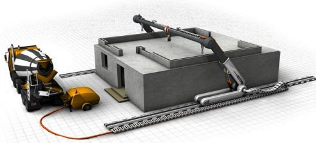
Система работает по принципу строительного крана, который возводит стены из слоёв бетона.
