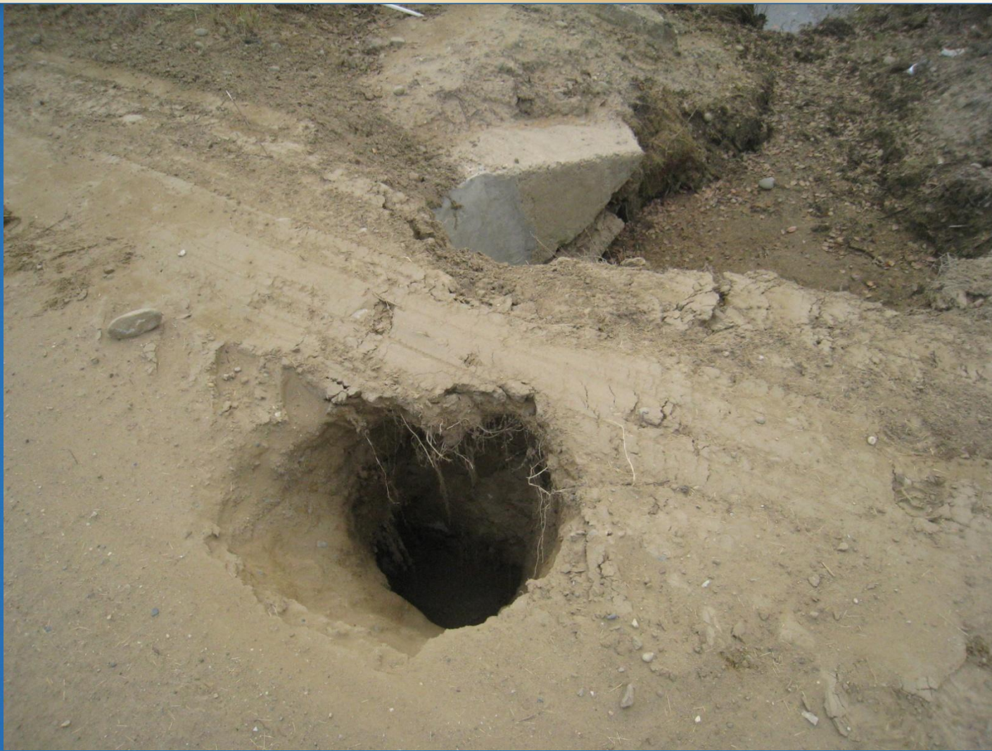
ПК 90+27, СУЩЕСТВУЮЩАЯ ДОРОГА «ВИЛЮЙ», ПРОВАЛ НАСЫПИ В ТРУБУ
