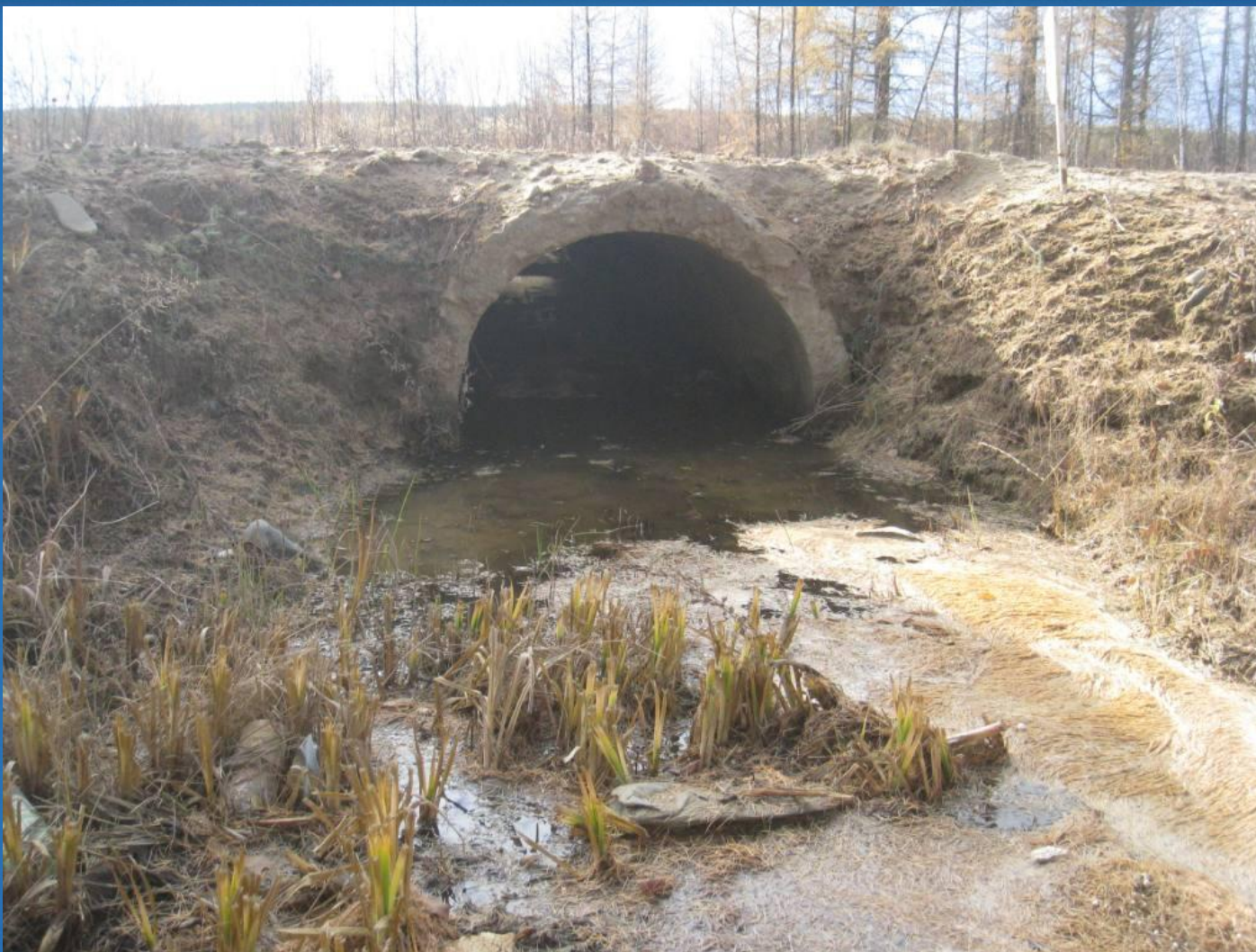
ПК 19+46, ТРУБА СУЩЕСТВУЮЩЕЙ АВТОМОБИЛЬНОЙ ДОРОГИ «ВИЛЮЙ», ВЫХОДНОЕ ОТВЕРСТИЕ
