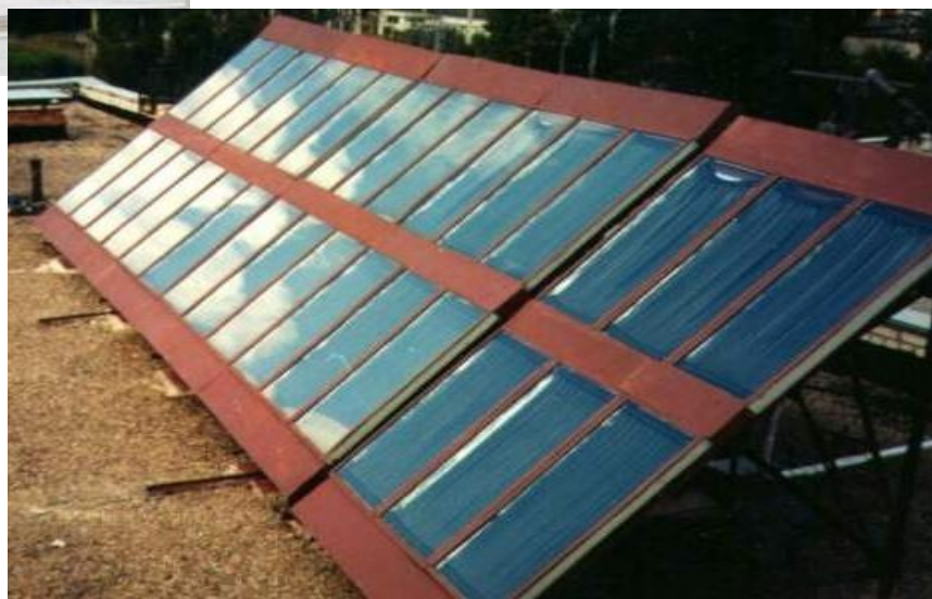
Экспериментальная гелиоустановка НАН Беларуси для подогрева воды
