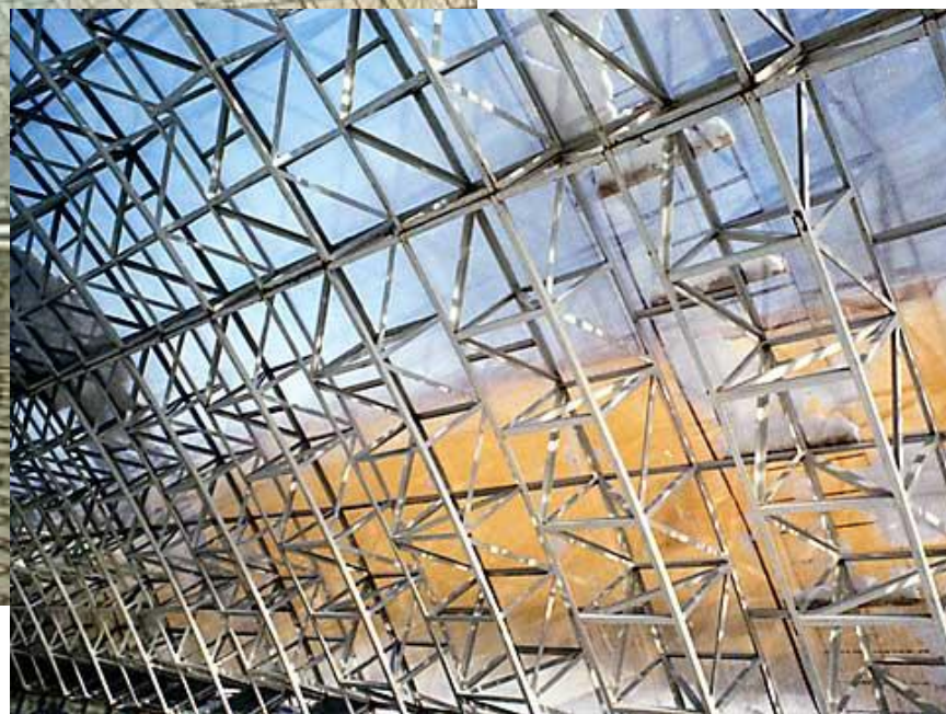
Арочное здание из алюминиевых объемных решетчатых арок
