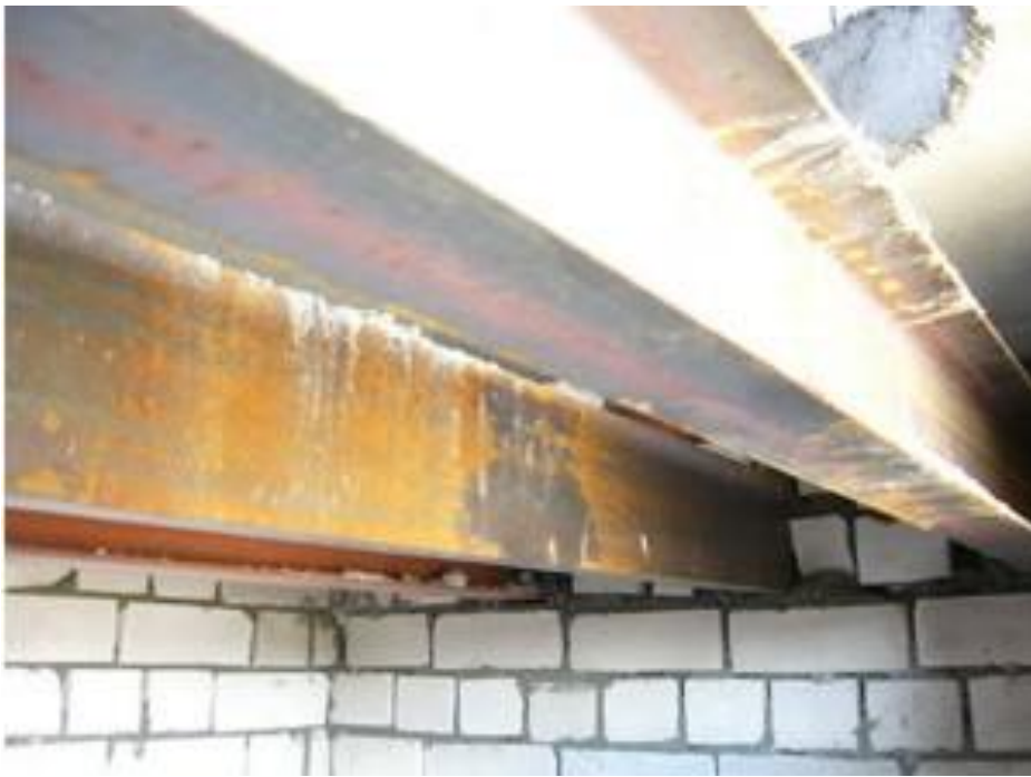
Поверхностная коррозия металлических элементов
