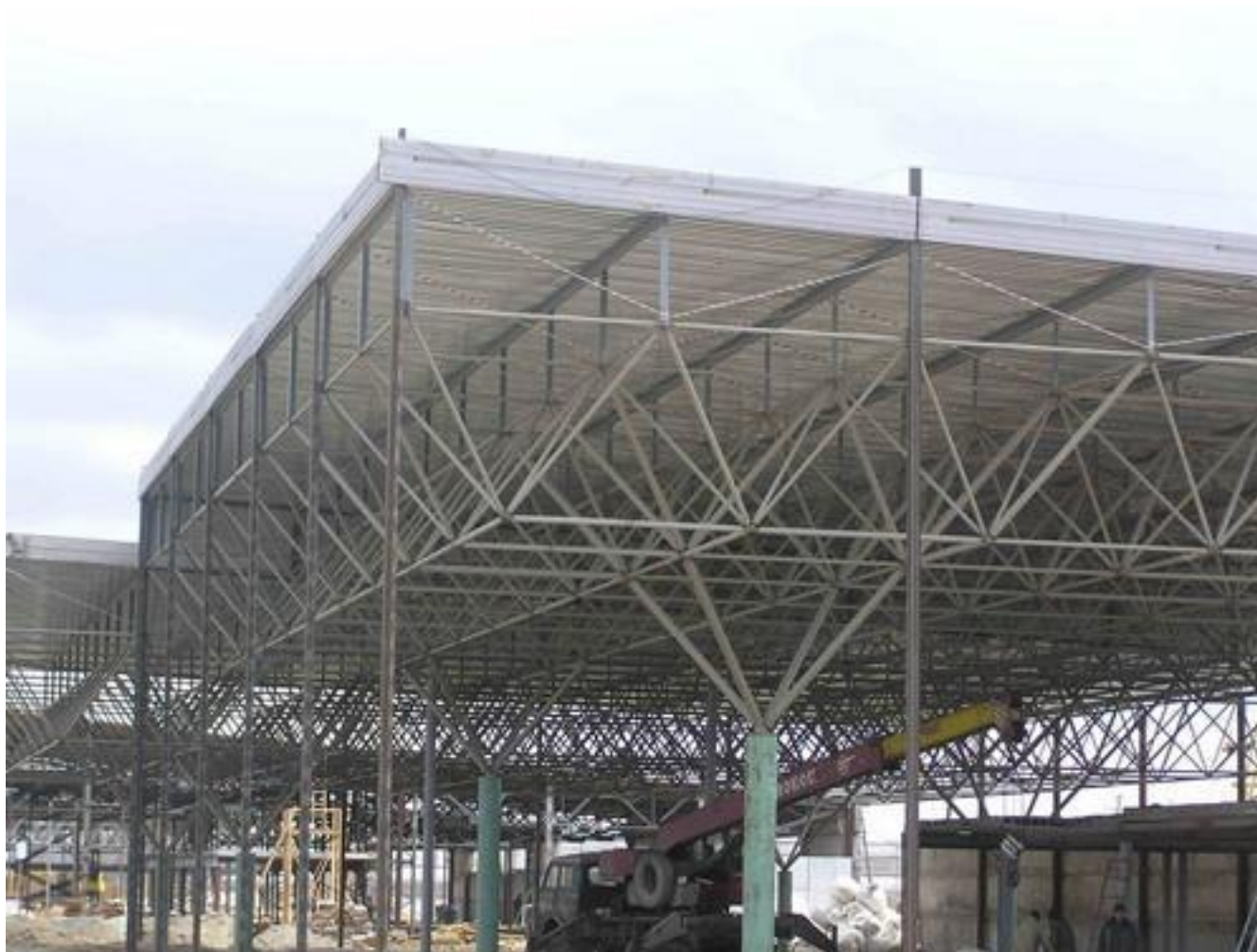
Каркас здания со структурной плитой «Кисловодск»
