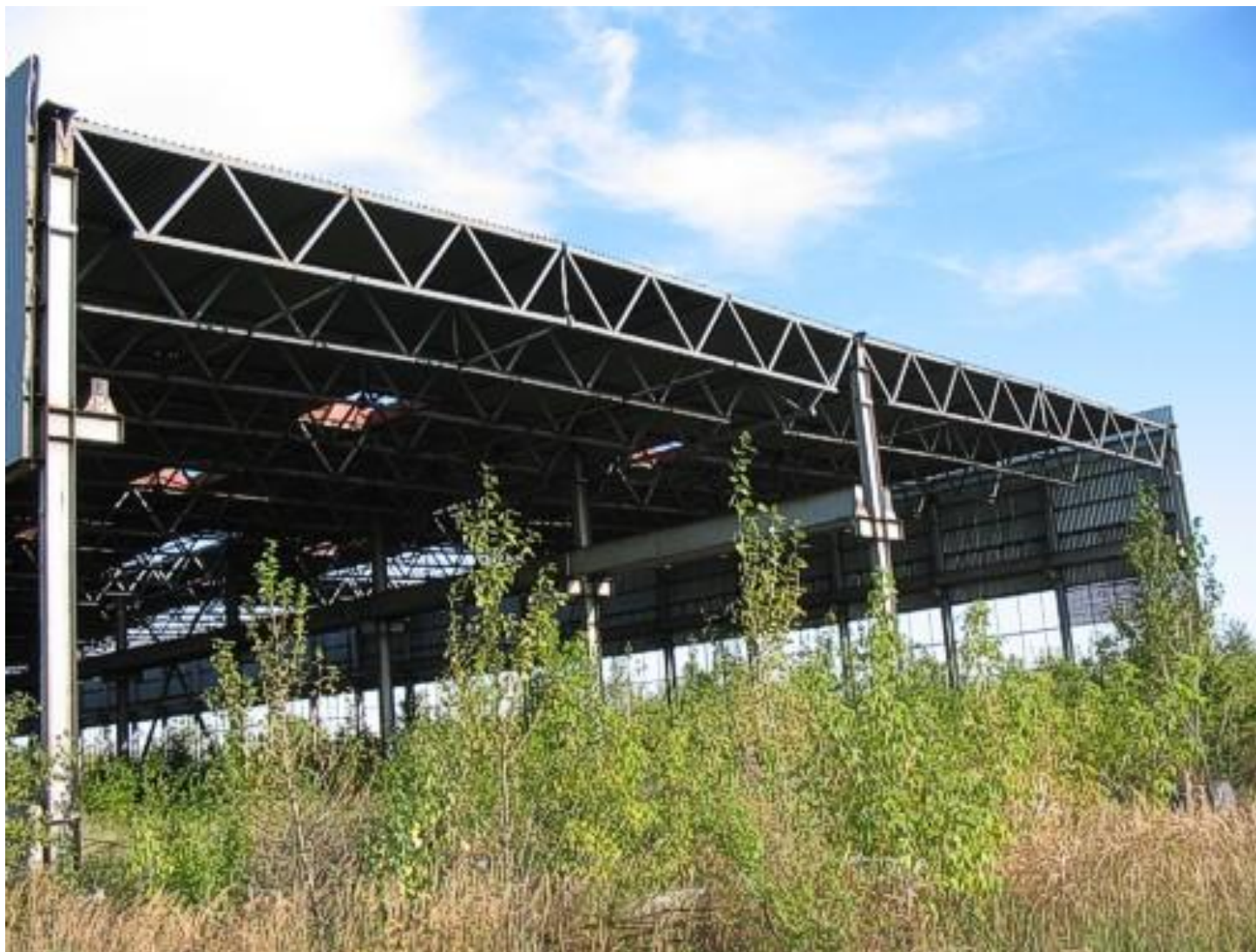
Каркас здания с фермами типа «Молодечно»
