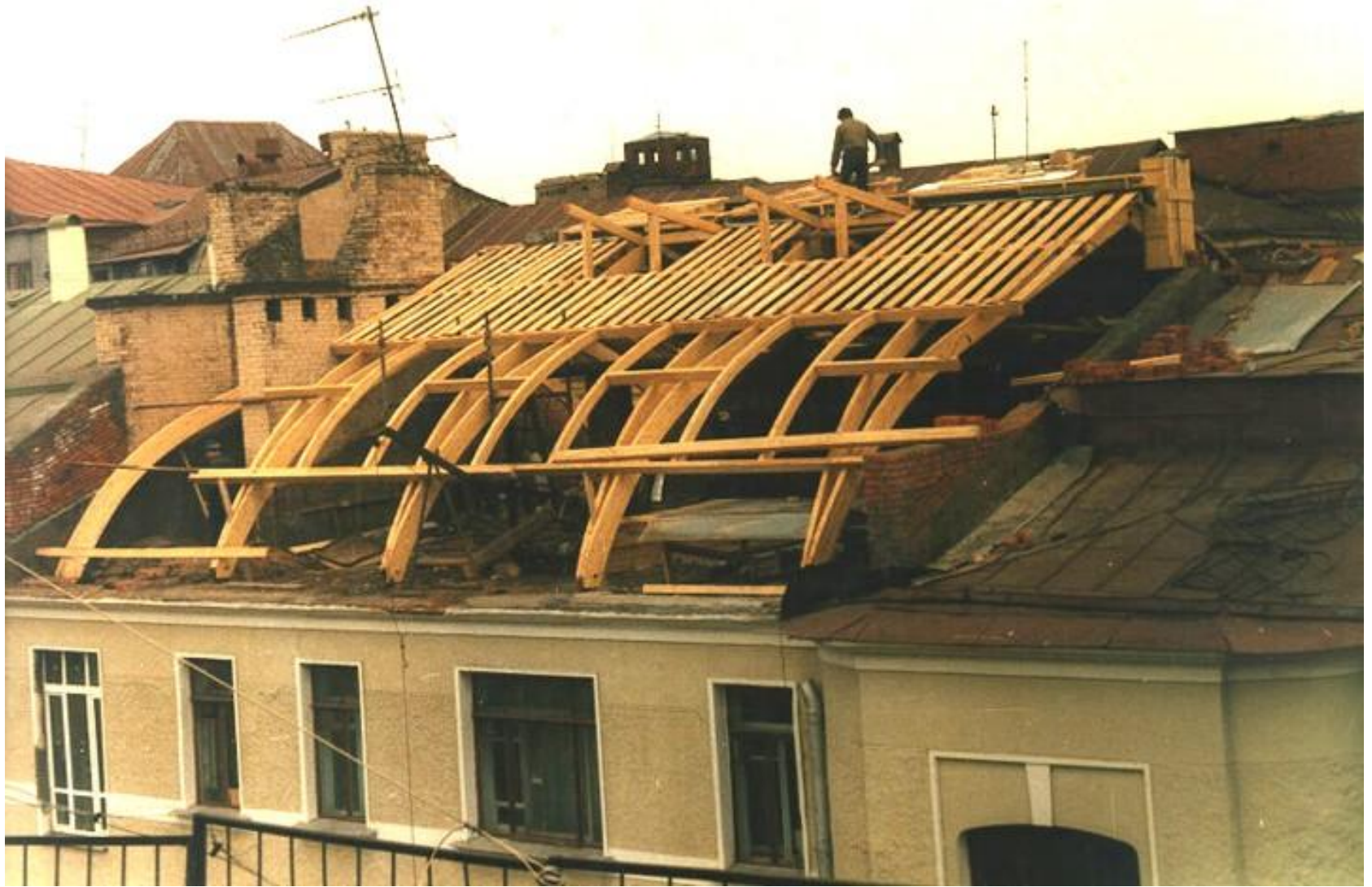
Конструкции каркаса мансарды
