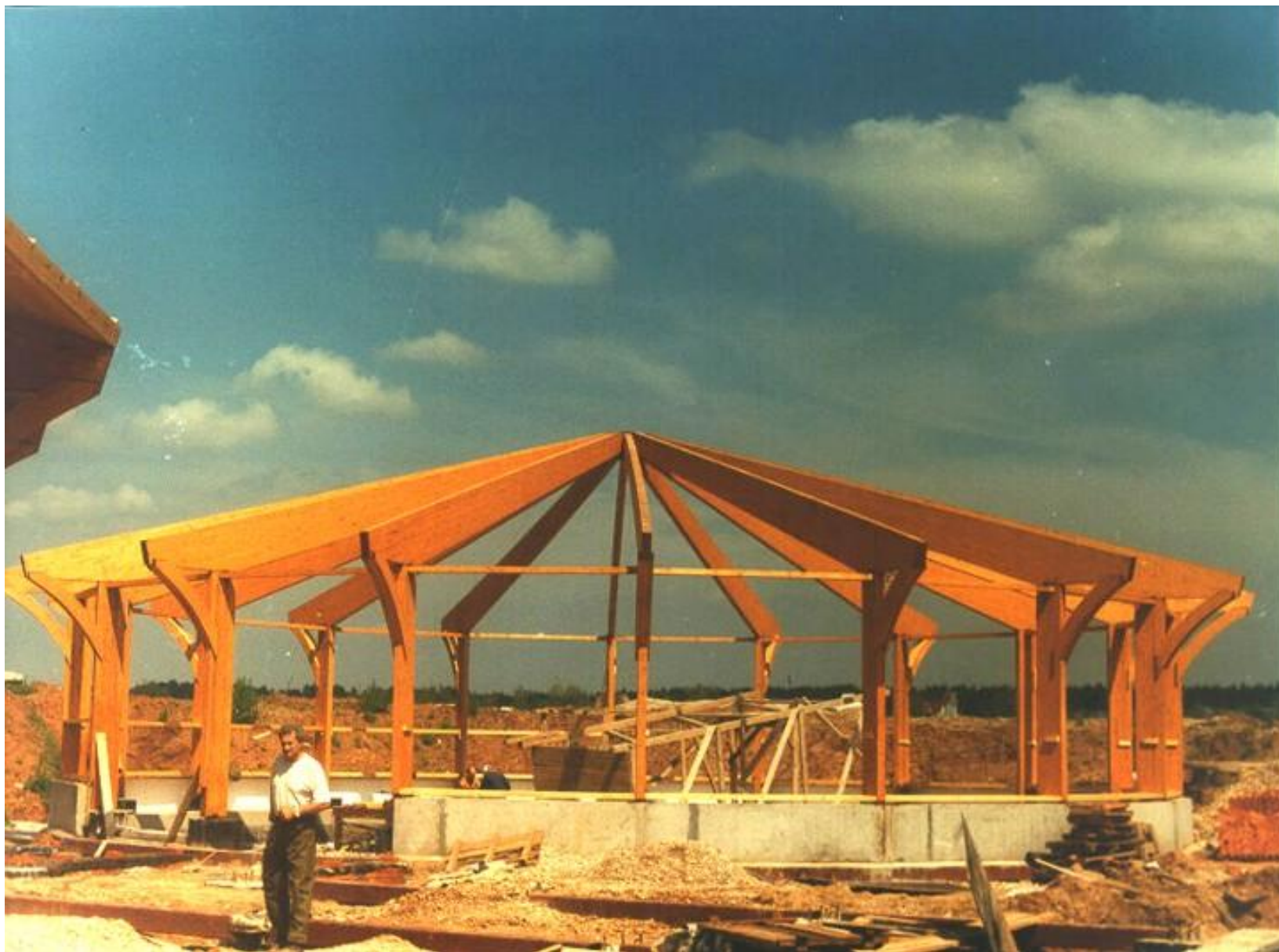
Конструкции конного манежа
