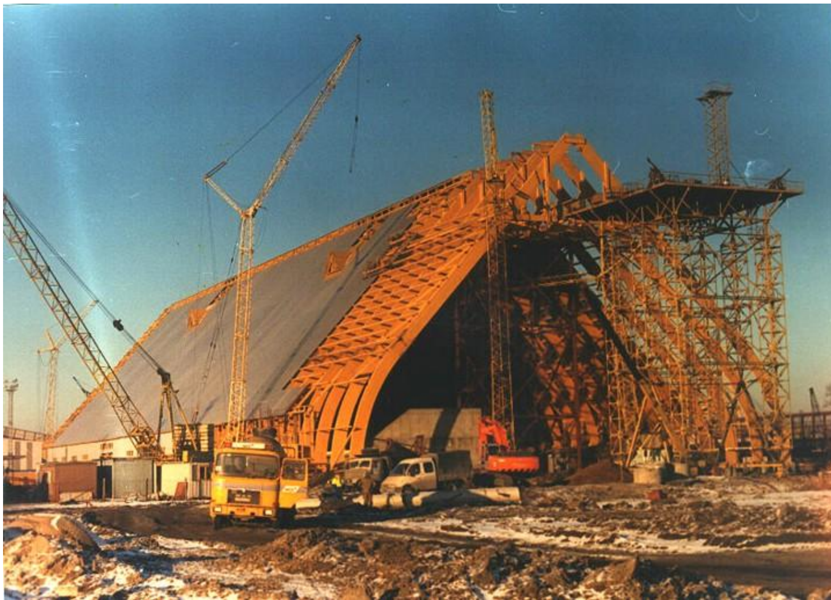
Конструкции склада калийных удобрений
