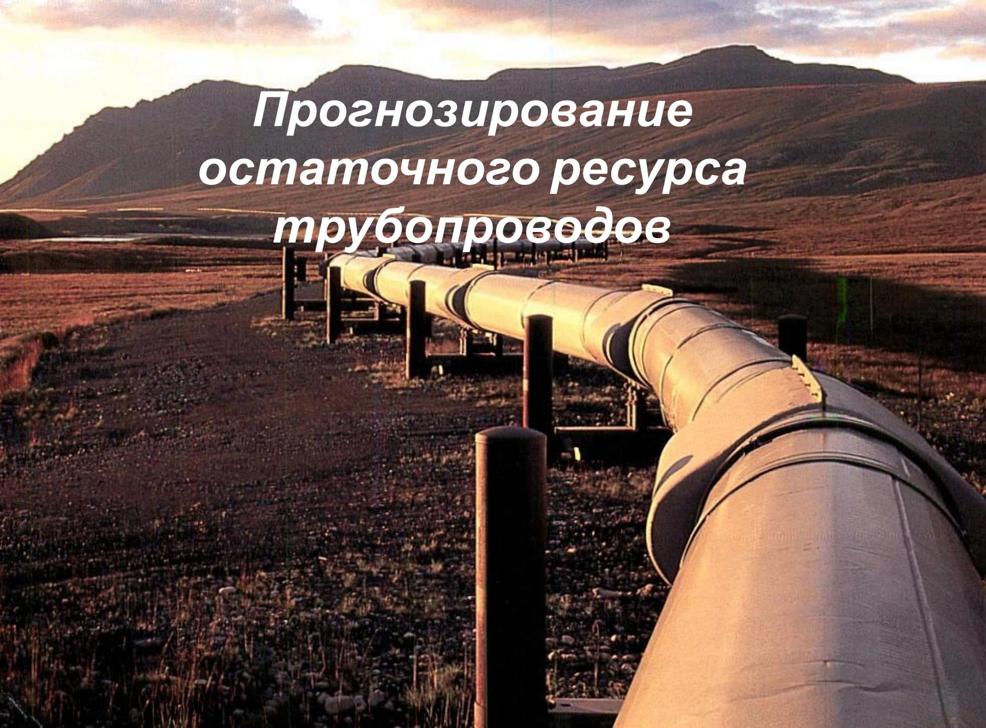
*Прогнозирование остаточного ресурса трубопровода базируется на результатах обследования технического состояния, исследования механических свойств и микроструктуры металла, оценки фактической нагруженности основных несущих элементов трубопровода и гидравлического (пневматического) испытания пробным давлением*
