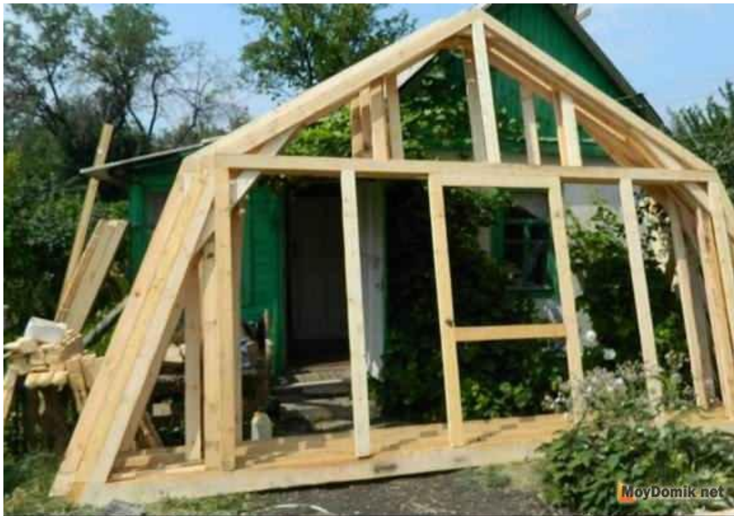
Сборка мансардного этажа
