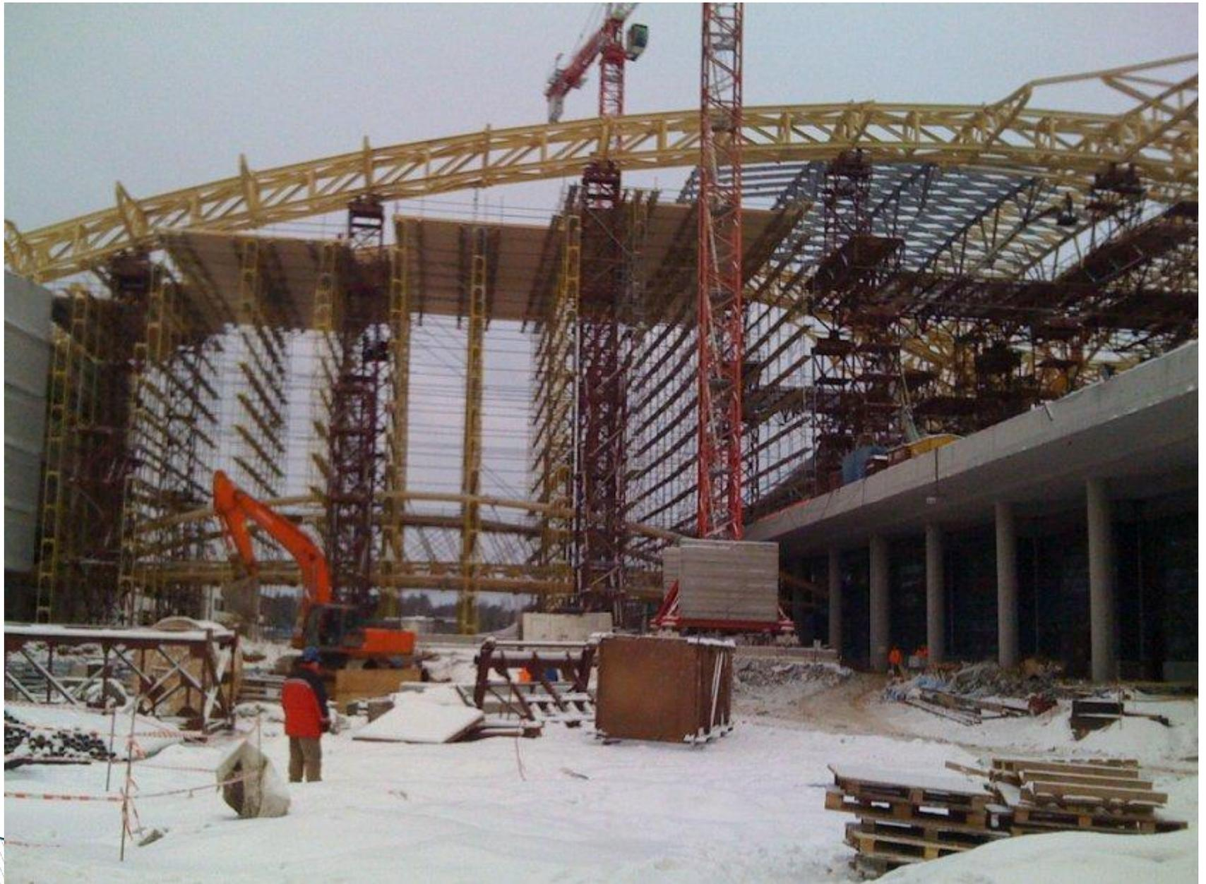
**Монтируемая первой несущая деревянная конструкция** после установки должна быть закреплена временными растяжками или другими приспособлениями.
