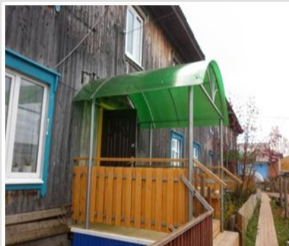
Ремонт подъездных крылец (ТОС «Берег»)
