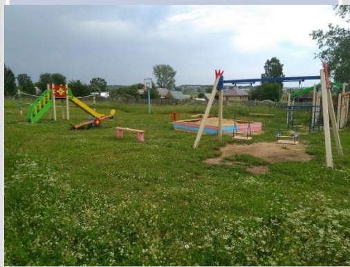
Строительство детской спортивной площадки (ТОС «Савинский»)
