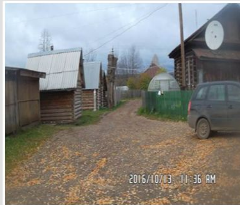
Ремонт и прокладка дорожно-тропиночной сети (ТОС «Перекресток»)
