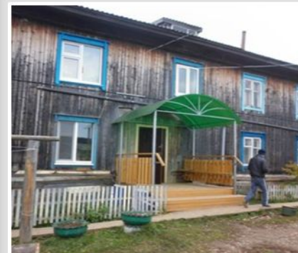
Ремонт и прокладка дорожно-тропиночной сети (ТОС «Берег»)
