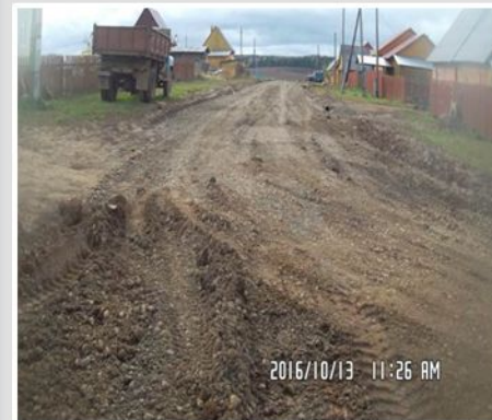
Текущий ремонт улично-дорожной сети по ул. Тихая (ТОС «Тихий Урал»)
