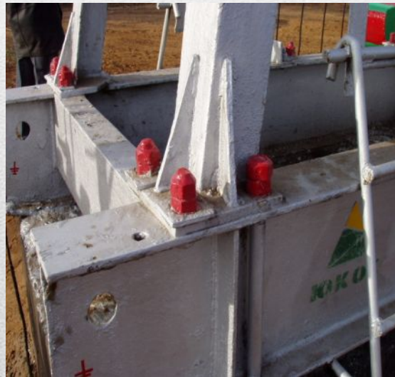
Осмотр болтовых соединений
