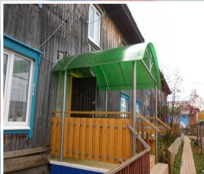
Ремонт подъездных крылец (ТОС «Берег»)
