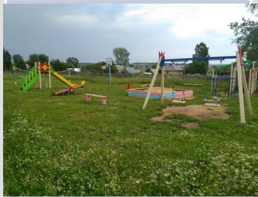
Строительство детской спортивной площадки (ТОС «Савинский»)
