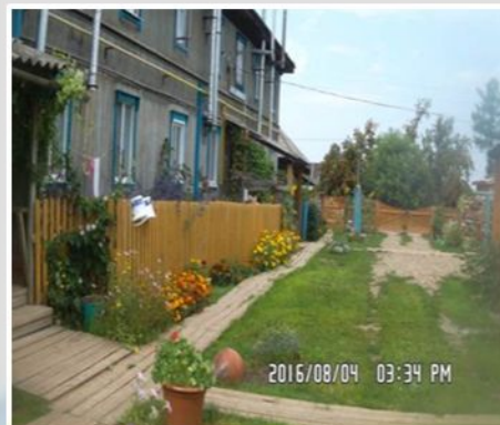
Ремонт входного подъездного крыльца многоквартирного дома (ТОС «Родник»)
