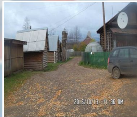
Ремонт и прокладка дорожно-тропиночной сети (ТОС «Перекресток»)
