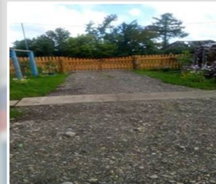
Ремонт и прокладка дорожно-тропиночной сети (ТОС «Родник»)
