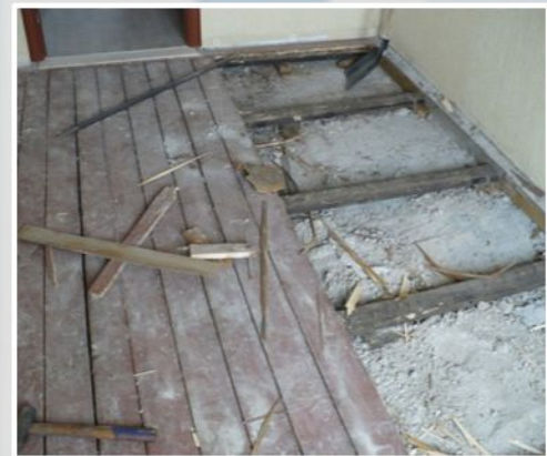
Ремонт утепленного входного тамбура, ремонт полов входной площадки (ТОС «Собственник»)
